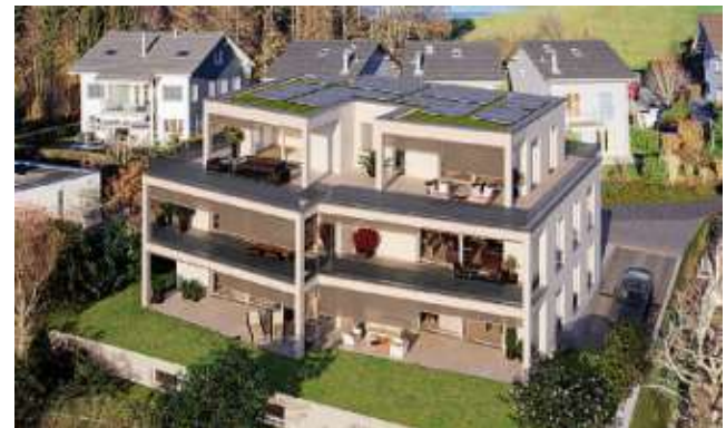
Neubau MFH Sonnenberg, Menzingen/ZG
